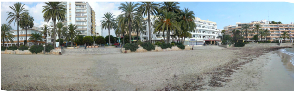
Figura 29. Apreciem les obertures d'accés i els efecte de aixaragallament sobre la platja
