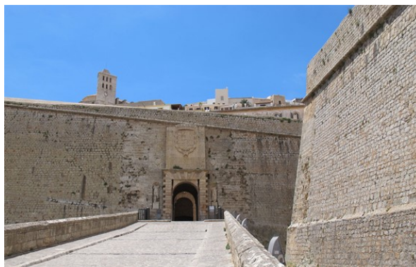
PORTAL DE SES TAULES: ACCESO PRINCIPAL AL RECINTO AMURALLADO
